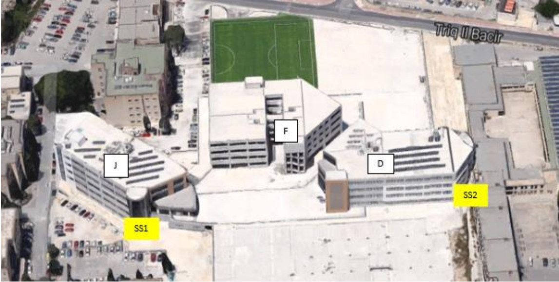
Şekil 4.1. MCAST pilot binalarının havadan görünüşü
